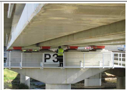
▲ 교량받침 점검로 근접조사
