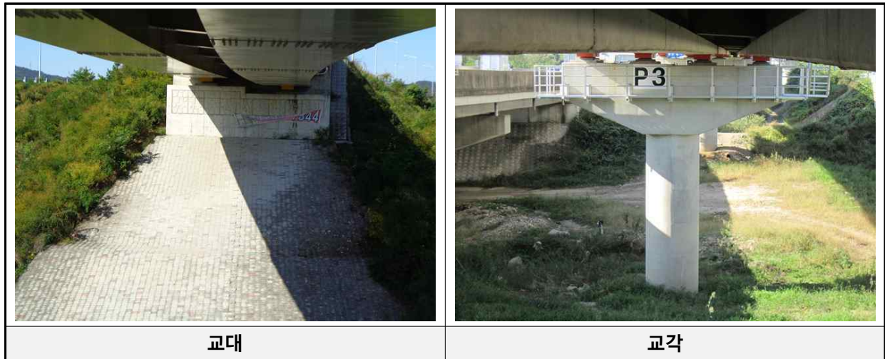
[교대 및 교각 전경]
